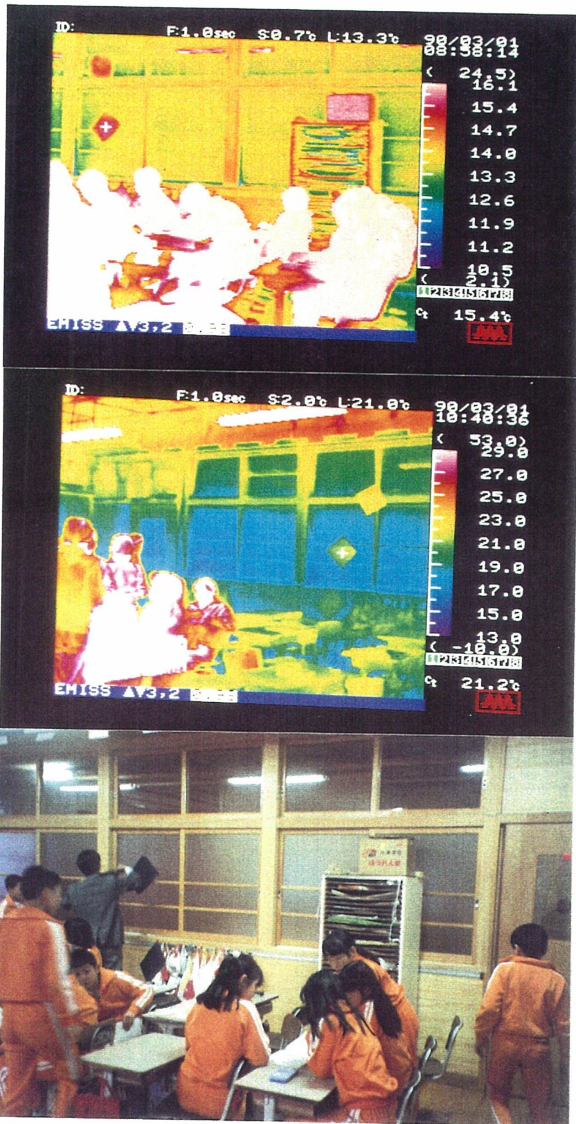
図5. 3. 4 木造2階教室北面のサーモグラフ 上：ストーブ点火前、 8時58分 中：ストーブ点火後、 10時41分 下：北面の写真
