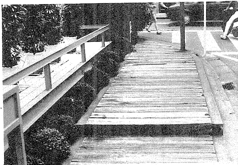
写真6 まくら木舗装 町田市内
