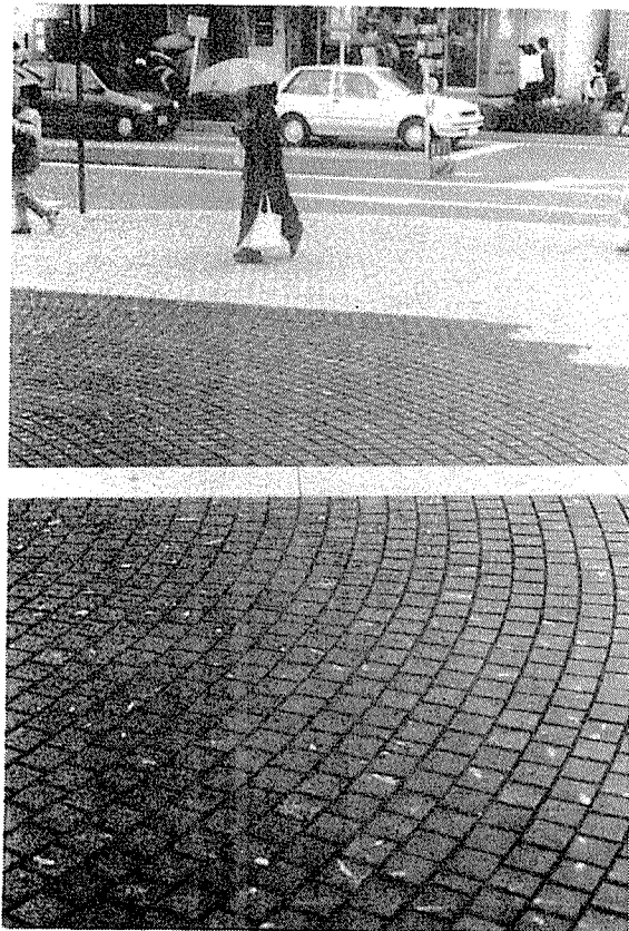
写真2 木れんが舗装、JR掛川駅前広場
