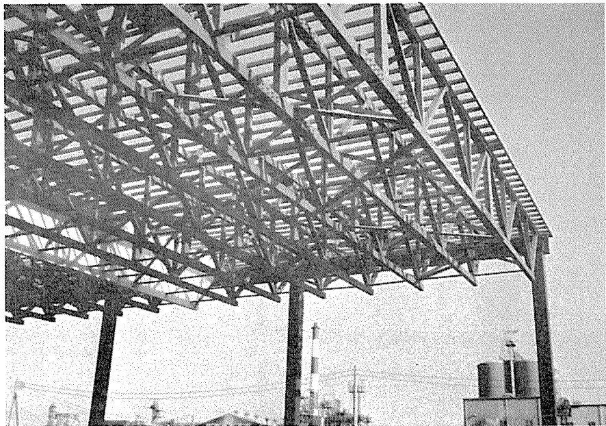
小屋組完了時、トラスの配列が美しい
