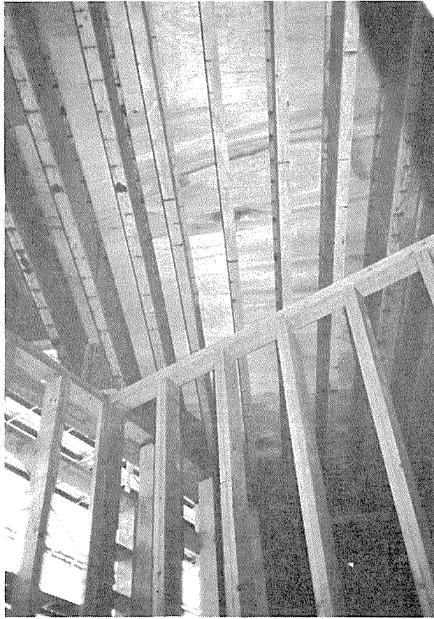
2階床根だに施工された木質I型複合梁
