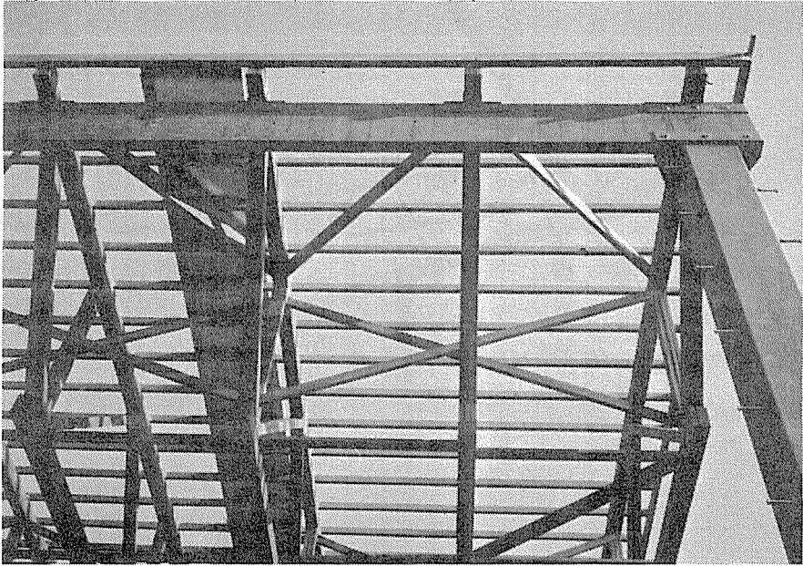
構造用単板積層材の桁材を仰ぐ
