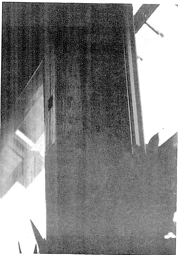
インサイジングされた枕木を抱き合わせて柱材としてある
