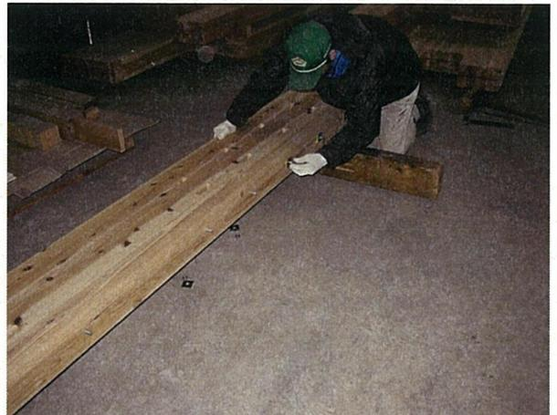
写真 2.2-17 ボルト、ナットの仮締め
