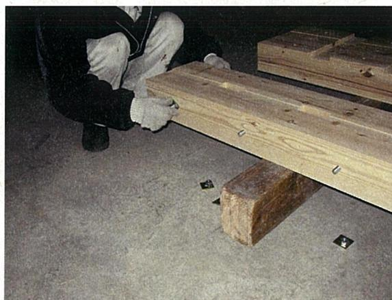
写真 2.2-8 ナットの仮締め
