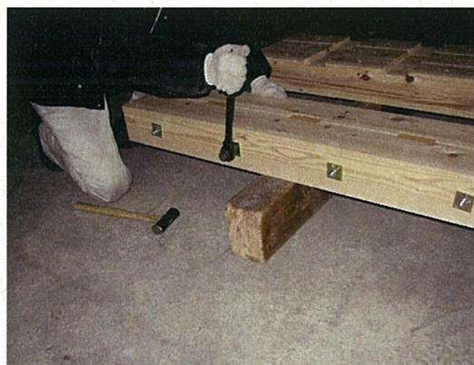
写真 2.2-12 ボルトを締める
