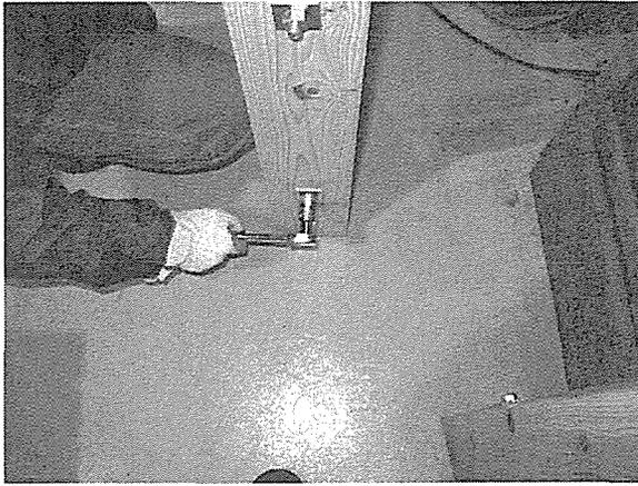
写真 2.4-1 トルクレンチでのボルトの締め付け
