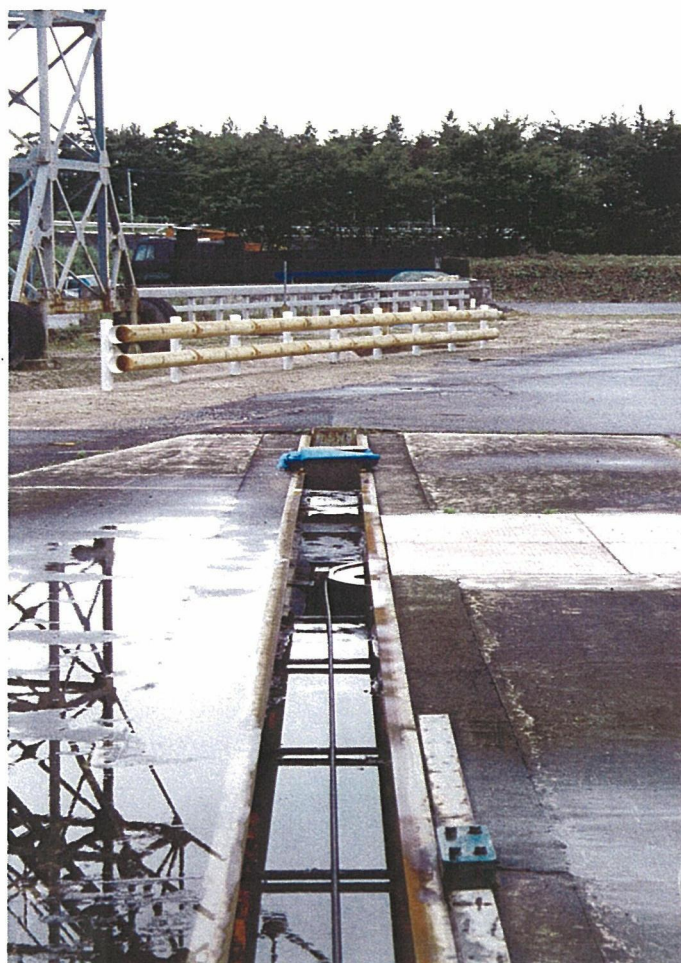
写真 2-1 車両走行方向から見た防護柵
