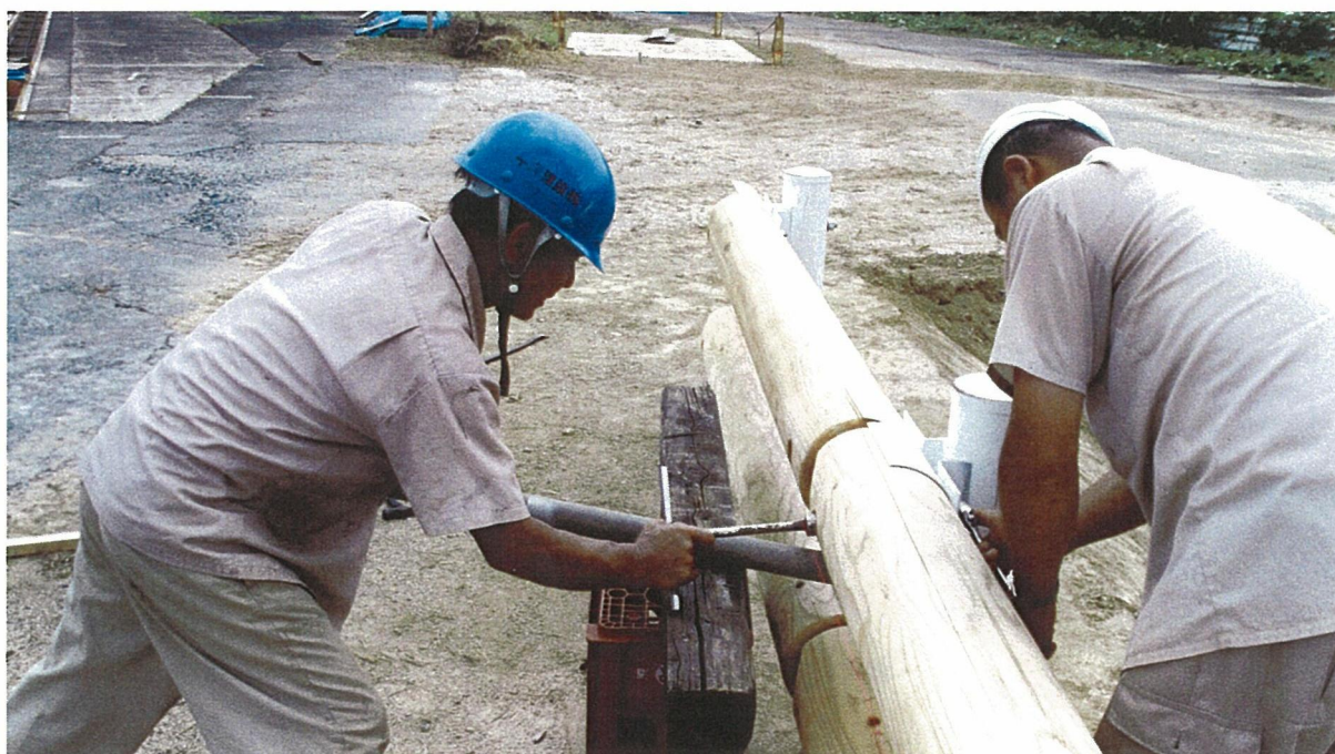
写真 2-3 防護柵取り付け風景
