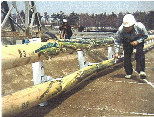
写真II-2 大型貨物衝突実験 (B3-B5衝突部分)
