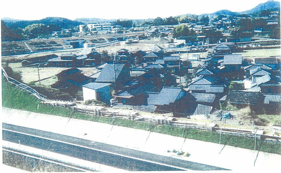
写真Ⅲー2 遮音壁設置前の臼杵市野田地区
