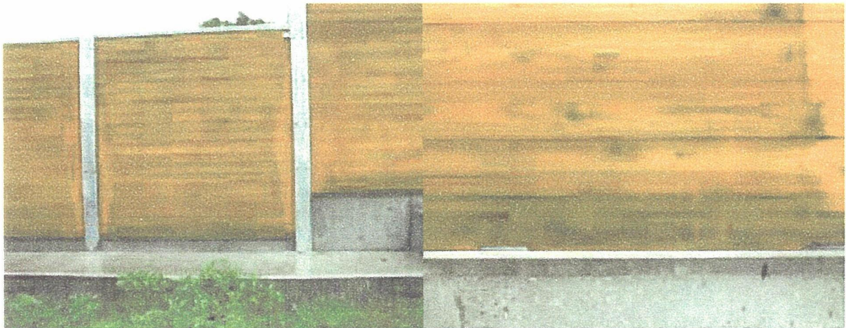
写真3-1 遮音壁の外観
