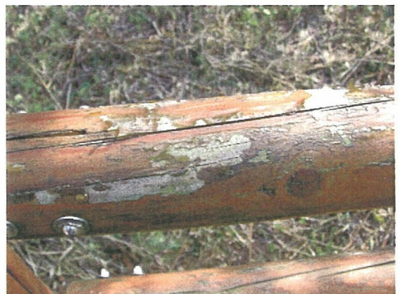
写真1-4 塗料の劣化
