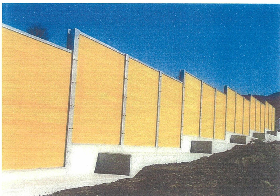
写真Ⅲ-5 設置遮音壁の背面（住宅側）
