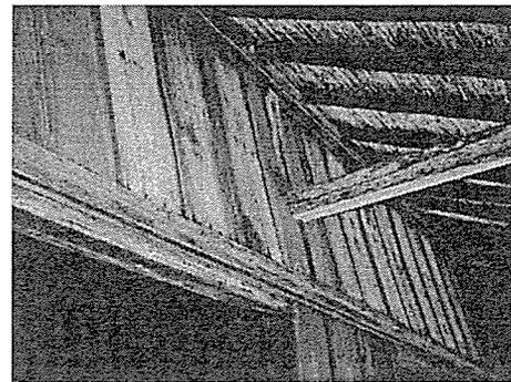
写真 1-29 霜覆い(柱や鴨居の腐朽対策)
